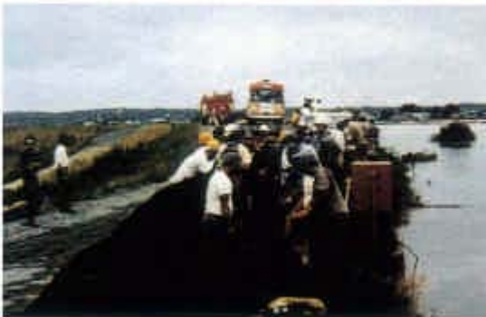
水防作業状況 (下繁田地区)
