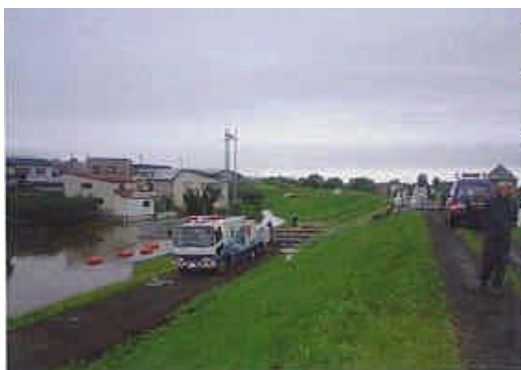
水防作業状況 (三世寺地区)
