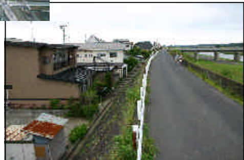
■三本木基準点左岸の特殊堤および近接する背後地の民家等→
