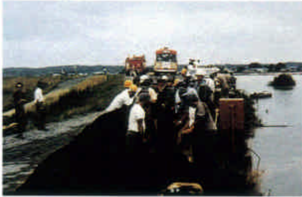
昭和 52 年 8 月洪水の水防作業状況 しもしげた (下繁田地区)
