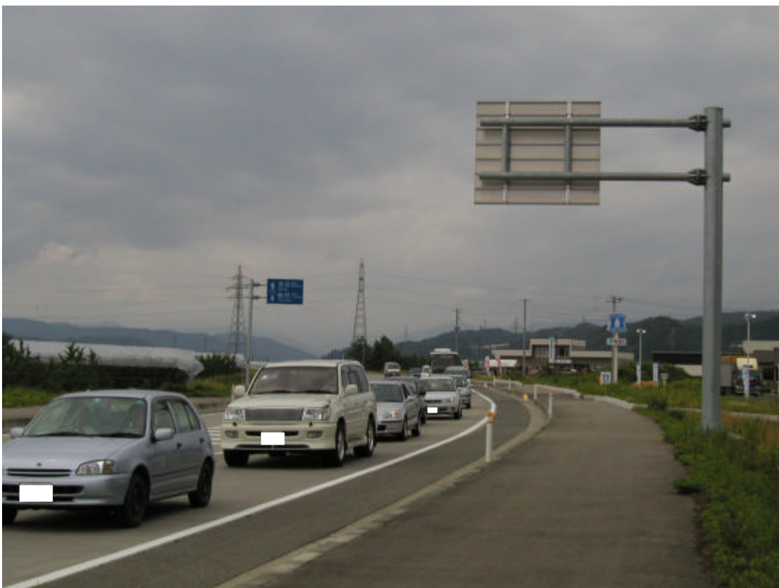
【供用後の白岩バイパス（西川町方面を望む）】
