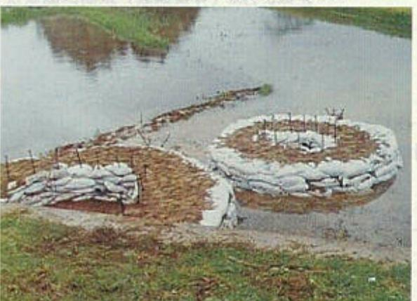
左岸 5.2km 付近(押分地区)月の輪工・釜段工
