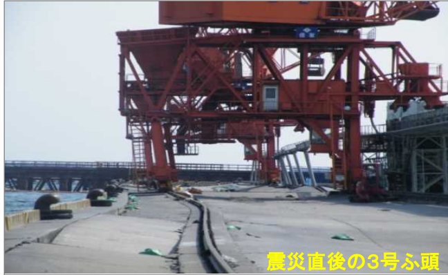
東日本大震災における石炭取扱岸壁被災状況
