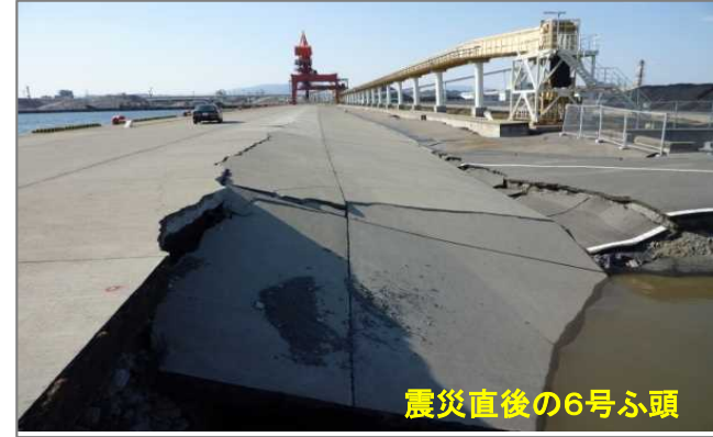
東日本大震災における石炭取扱岸壁被災状況
