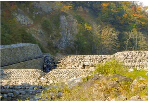
石張りの砂防堰堤 (葛根田川第一砂防堰堤)
