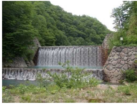
化粧型枠を使用した砂防堰堤 (先達川第一砂防堰堤)
