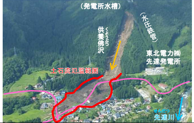
■平成25年8月発生 供養佛土石流災害
