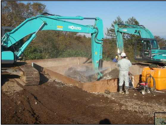
現地発生材を使用したINSEM工法を 採用した縮減例 (クラカケ沢砂防堰堤: H25完成)
