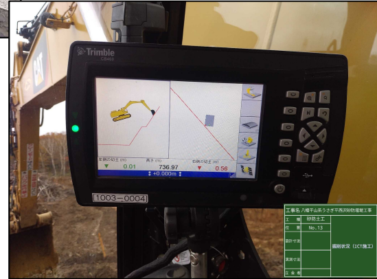
ICTを活用して土工管理をした省力化例 (うさぎ平西沢砂防堰堤: 施工中)
