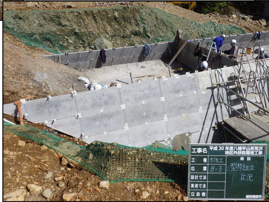
残存型枠を用いて 施工した縮減例 (荒沢砂防堰堤: R1完成)
