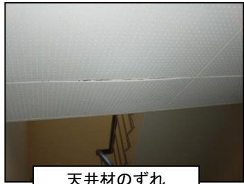
天井材のずれ
