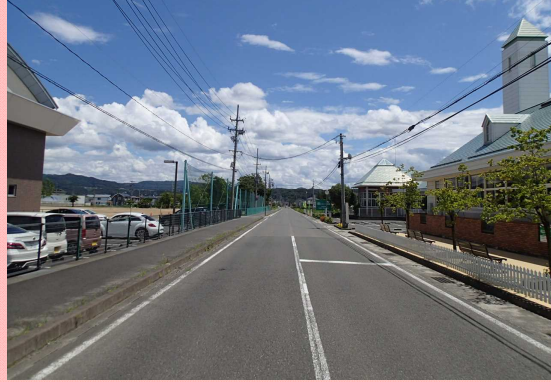
▼道路幅員が広く、歩道も確保されている。
