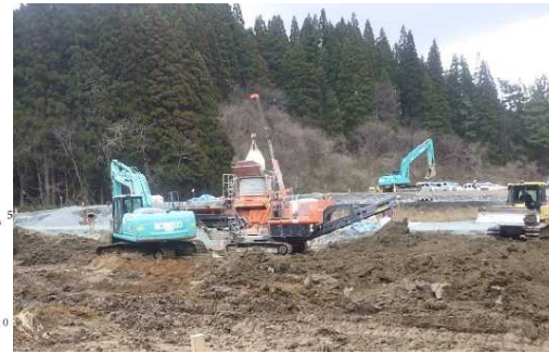
▲土質混合機械での作業状況
