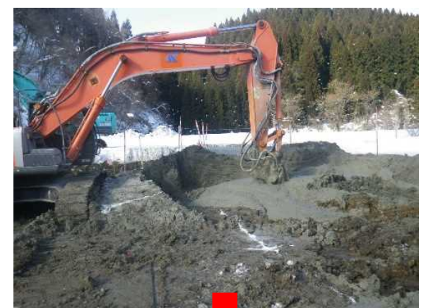
▼中層混合(パワーブレンダー工法)
