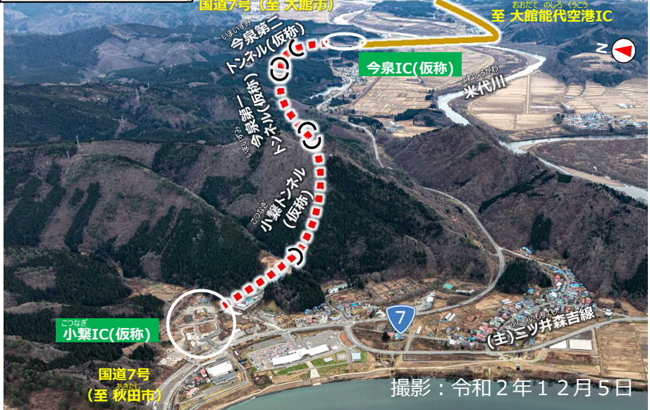
①起点側からの全景
