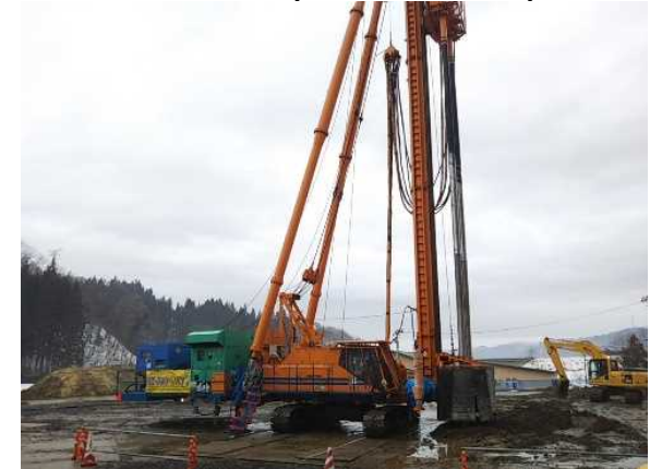
▼深層混合(スラリー攪拌工)
