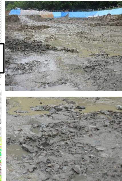
▼ 函渠床掘(礫混り土砂)
