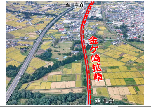
① 起点側より終点方面を望む
