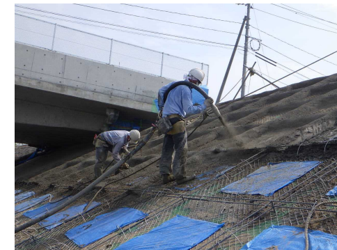
▲簡易吹付法砕工施工状況
