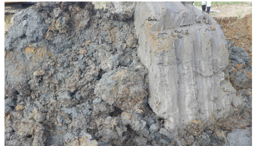
▲ 施工途中確認の高含水比の土質状況 (改良前)
