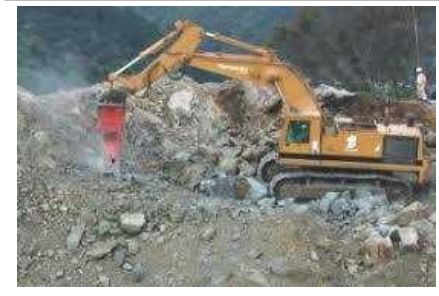
中硬岩・硬岩掘削(ブレーカー掘削)
