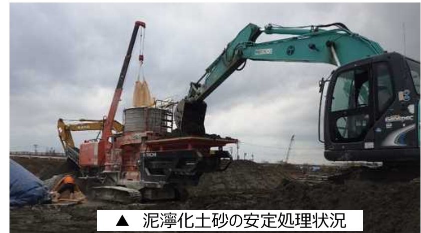
▲泥濘化土砂の掘削状況
