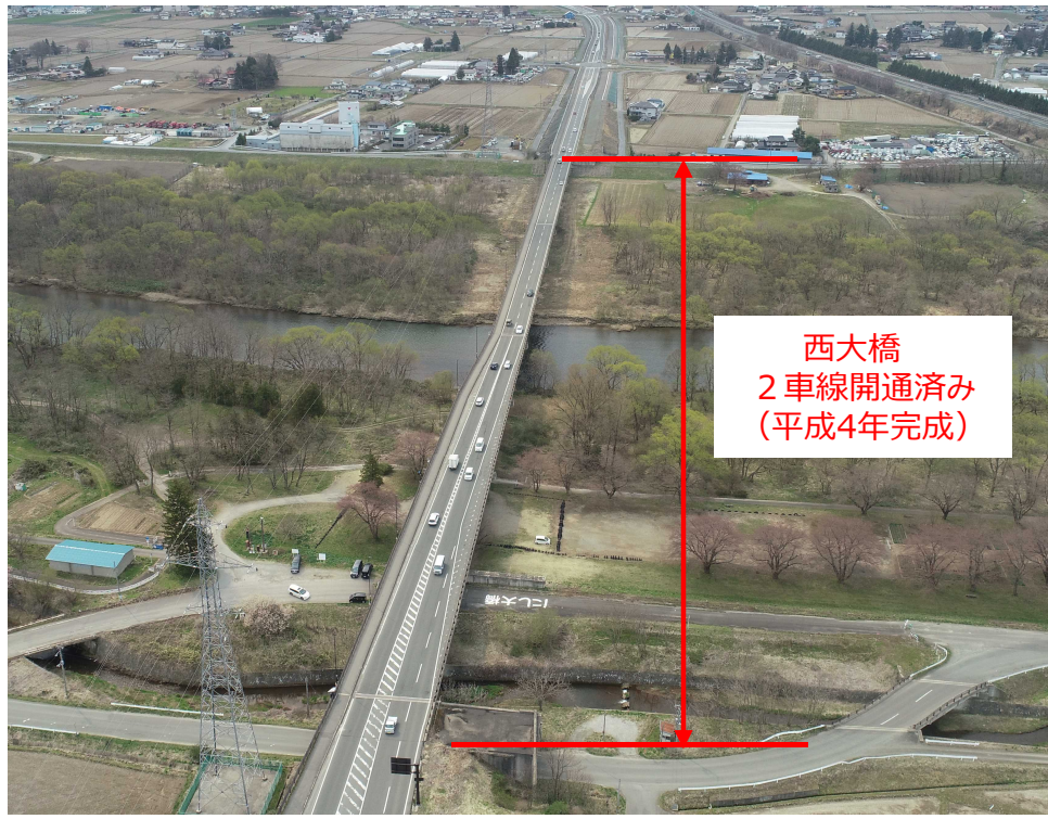
①道路橋示方書の改定に伴う 橋梁構造の変更【西大橋】
