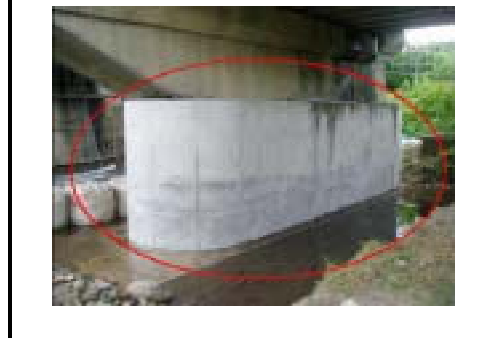
橋脚補強の実施例
