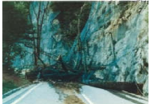
現283号 災害発生状況
