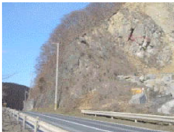
国道45号(石巻市成田)に隣接した法面状況
