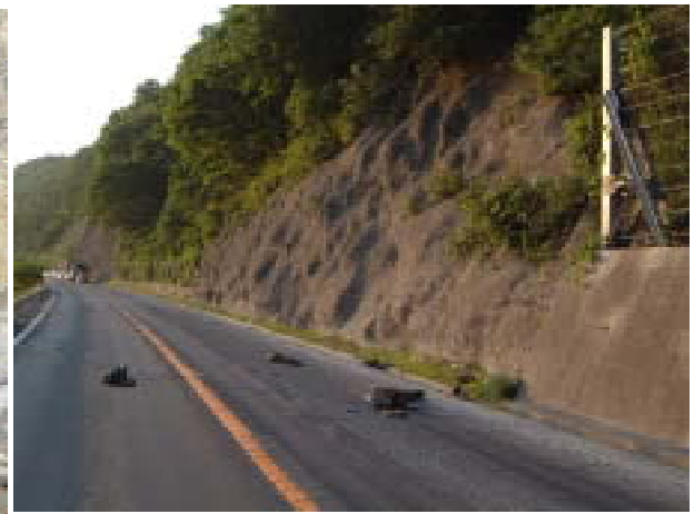
国道45号への落石状況
