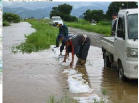
雄物川における水防活動(平成16年7月)
