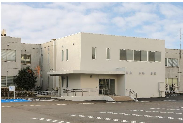
[写真] 増築庁舎 北側外観
