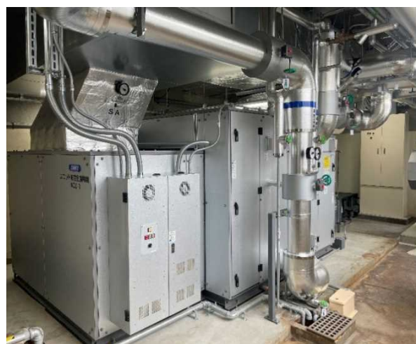
【空調機械室 施工後】
