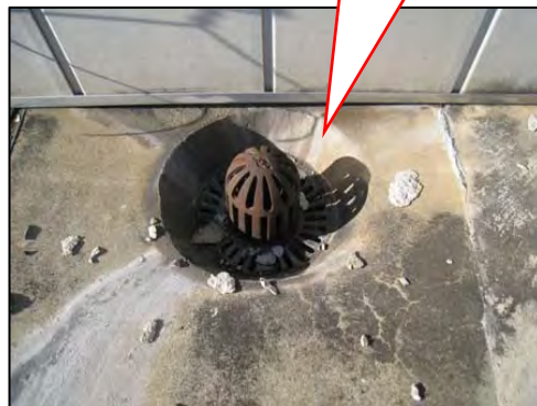
ルーフトレン部の現況
