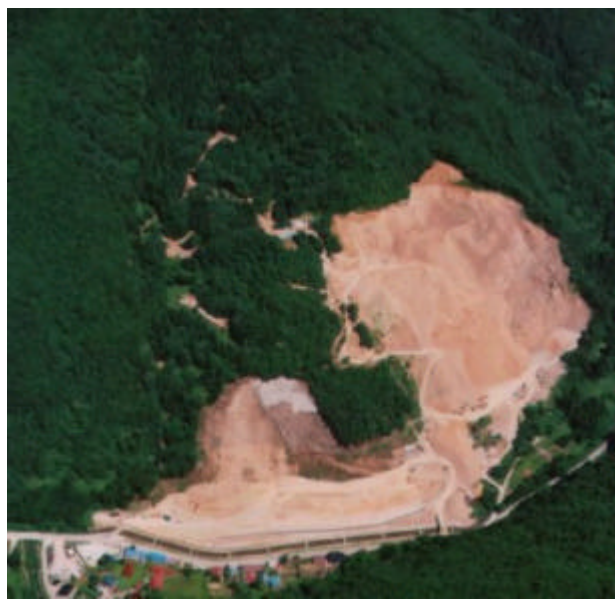
泉郷災害関連地すべり対策事業実施状況
