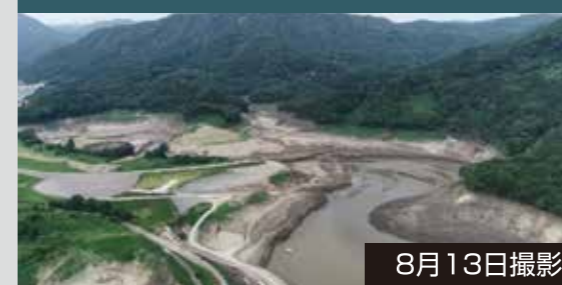
貯水量が低下した津軽ダム
