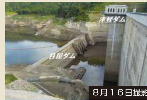
8月16日撮影 管理移行後、一番低い貯水位となった津軽ダム(最低水位まで残り2.1m)
