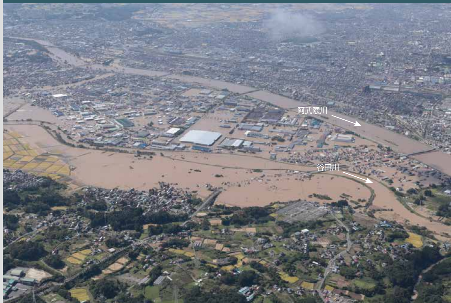
浸水状況(福島県郡山市)
