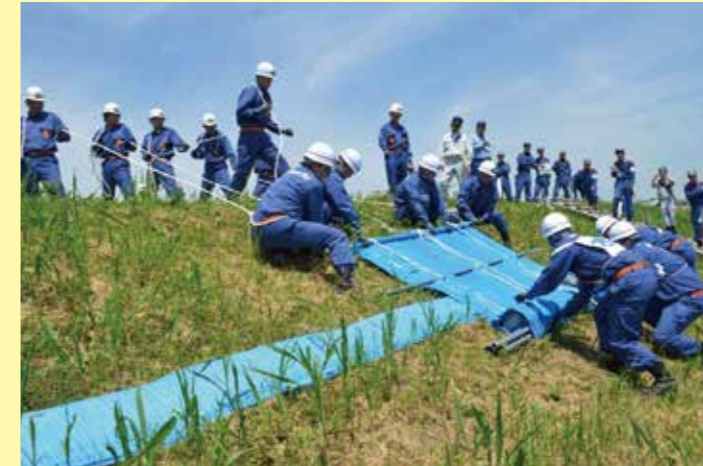
シート張り工
