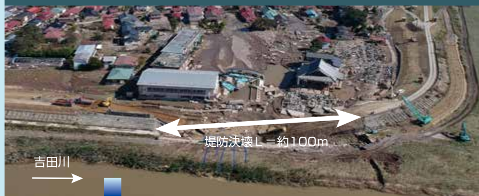
10月13日 被災状況
