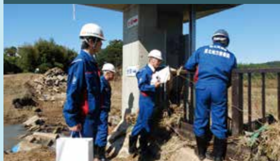
堤防決壊箇所調査状況
