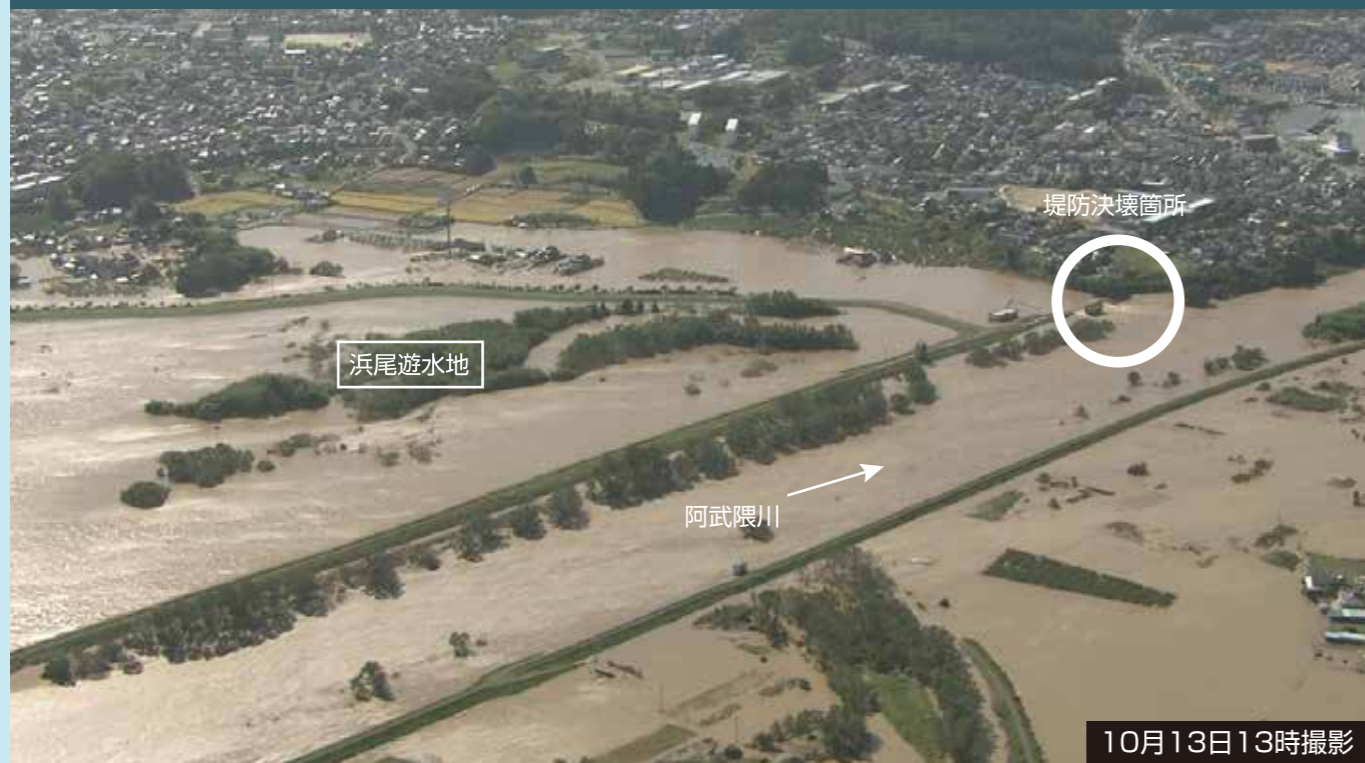
阿武隈川上流 98.6k付近 福島県須賀川市
