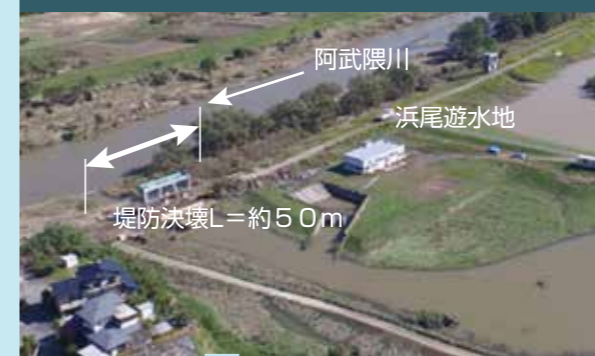
堤防の被災状況
