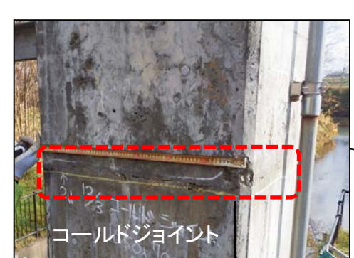
みかわじり 【三河尻排水樋管】30年経過(1986年) 須川 左岸8.5km B2.0×H2.3×L30.7m 継目なし 2連 杭基礎
