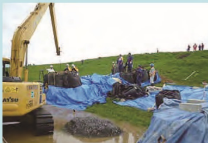
月の輸工による漏水対策を実施
