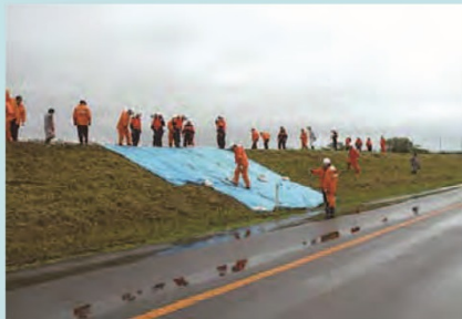
シート張り工により堤防の洗掘対策を実施
