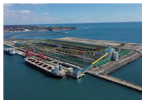
エネルギー供給拠点
