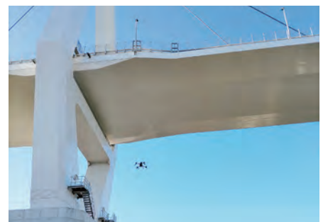
ドローンによる橋梁点検
