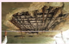
事後保全段階の橋梁補修
