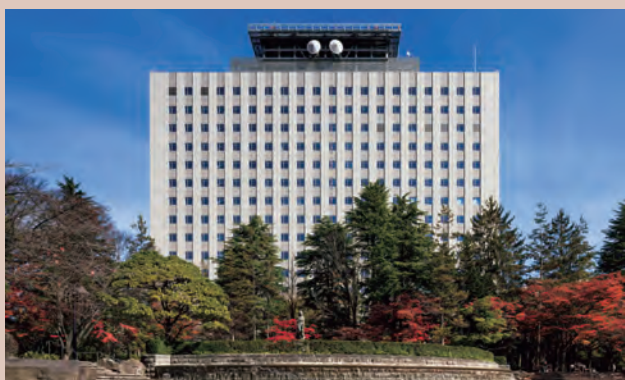
仙台合同庁舎B棟(宮城県仙台市)
