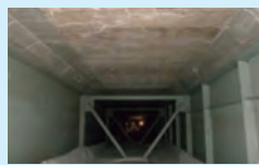
予防保全段階の橋梁補修
