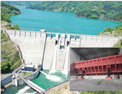
ダムゲート設備
