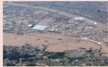
令和元年10月台風第19号(東日本台風) 福島県郡山市 阿武隈川(国管理)
