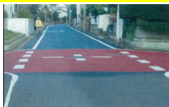
交差点カラー舗装
