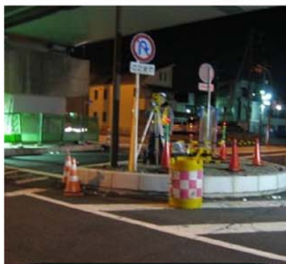
車道規制外からの計測状況
