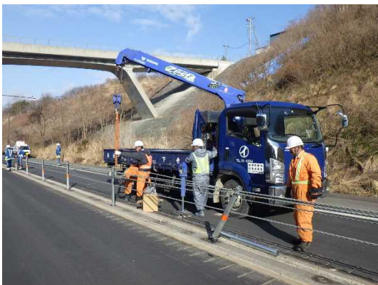
▲事故後の復旧作業の状況
