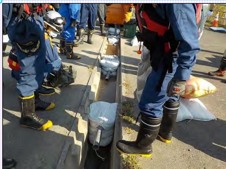
▲側溝での土のう積工法▲
