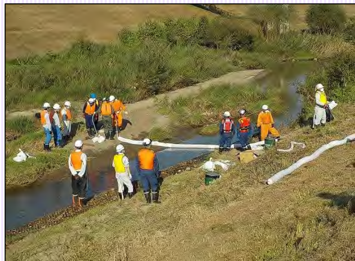
▲オイルフェンスの展張▲
