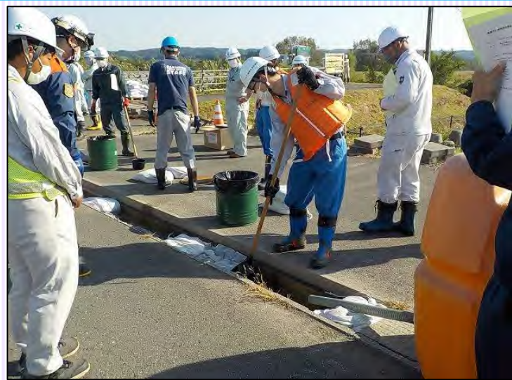
▲側溝での土のう積工法▲
