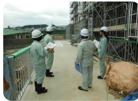
▲厩内排水ポンプ場の現場見学
