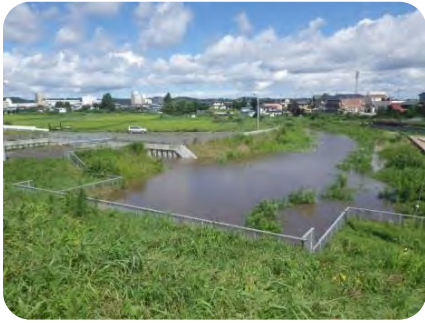
▲8月23日 水位上昇した支川の浅水川
