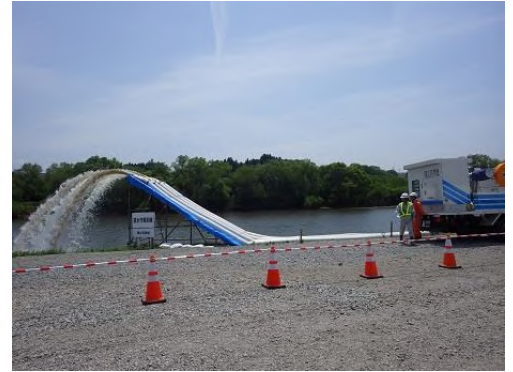
▲国交省による排水ポンプ車での 排水訓練の様子
