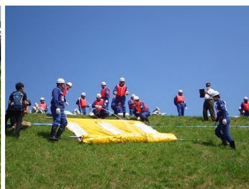
▲水防工法訓練の様子 (Tマット工) 堤防の漏水箇所、崩れた箇所を保護する工法
