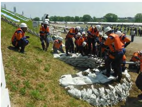
▲水防工法訓練の様子 (月の輪工) 堤防の漏水箇所拡大を防ぐ工法
