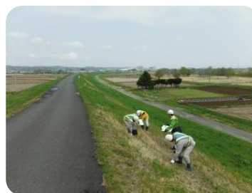
▲堤防法面 芝の状態(左)や、堤防舗装の状態(右)を確認しています
