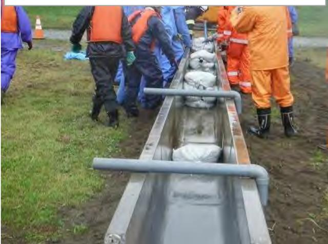
黄色いフェンスを排水路の出口と馬淵川との合流部に円形状に張る訓練です。設置後に吸着マットを投入して油を吸わせま
