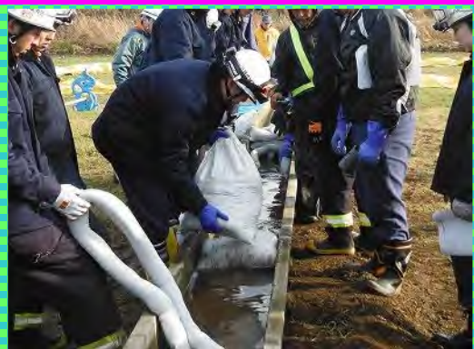
土のう、塩ビ管、オイルフェンスを 小型側溝に設置する訓練
