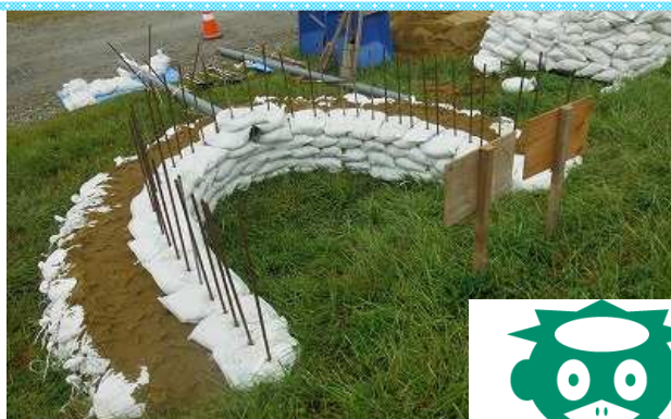
4 月の輪工 (堤防裏側に漏水により水が噴出し、その漏水口に土のうを積んで水の圧力を弱めて堤防の決壊を防ぐ工法です)
