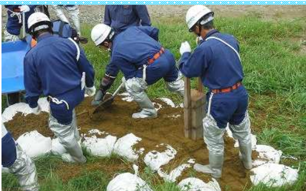
4 月の輪工 (堤防裏側に漏水により水が噴出し、その漏水口に土のうを積んで水の圧力を弱めて堤防の決壊を防ぐ工法です)
