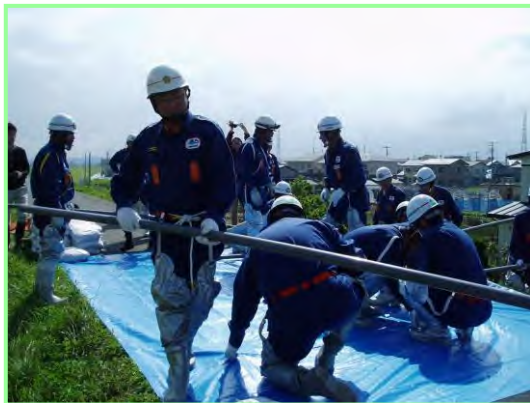
堤防が崩れ始めたら、ブルーシートで手当します(シート張工)
