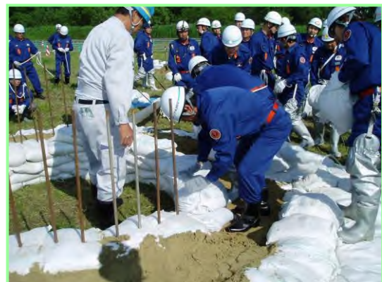
堤防の下から漏水！！そんなときの土のうの積み方を覚えました(釜段)
