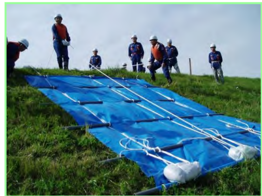
堤防が崩れ始めたら、ブルーシートで手当します(シート張工)
