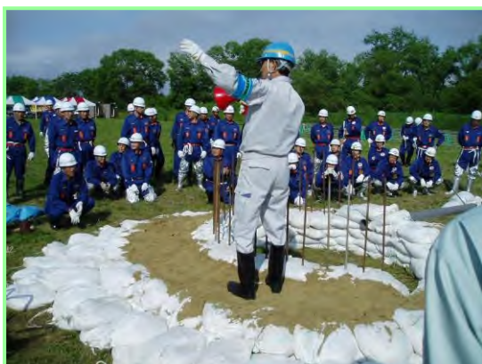
堤防の下から漏水！！そんなときの土のうの積み方を覚えました(釜段)
