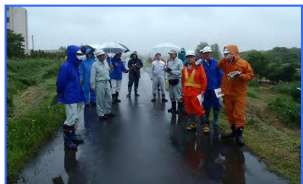
堤防が整備されていない一日市地区
