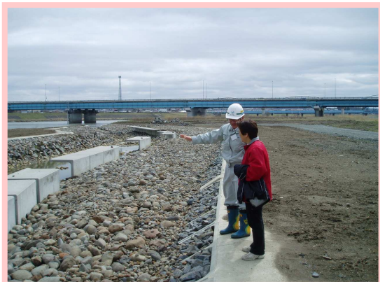
河川愛護モニター(市民からの公募)も参加。利用者の視点で点検して頂きました
