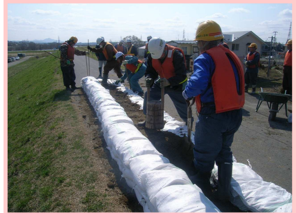
堤防を越える洪水に備え、土のうを積み上げる訓練です
