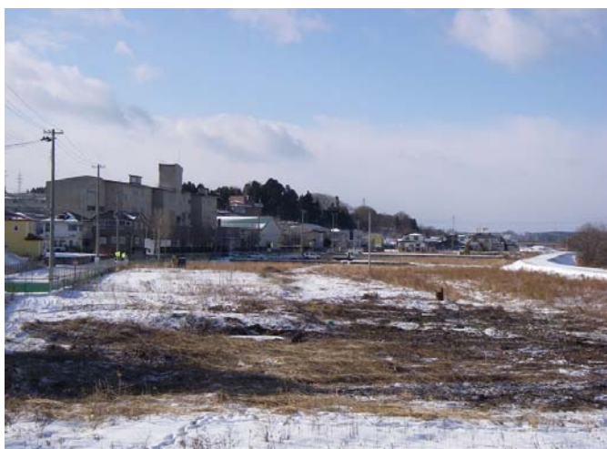
【工事施工箇所(着工前)】
