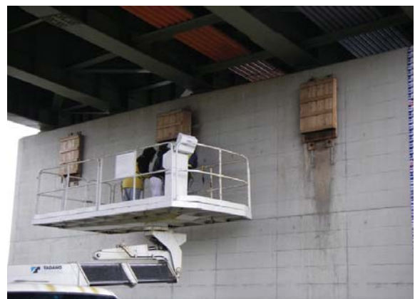
高所作業車を使って交換作業を行いました。
