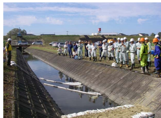
樋管排水路のような比較的狭い水路では、油吸着材入りの小型のオイルフェンスを設置。フェンスを2重に設置かつ、端部から漏れの無いように、吸着マットを追加。
