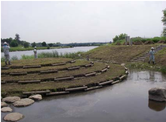
自然観察の場である、大橋下流「水辺の楽校」の点検状況。
