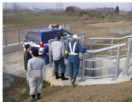
「排水樋門」等の施設周辺の水路への転落の危険がないか確認しています。
