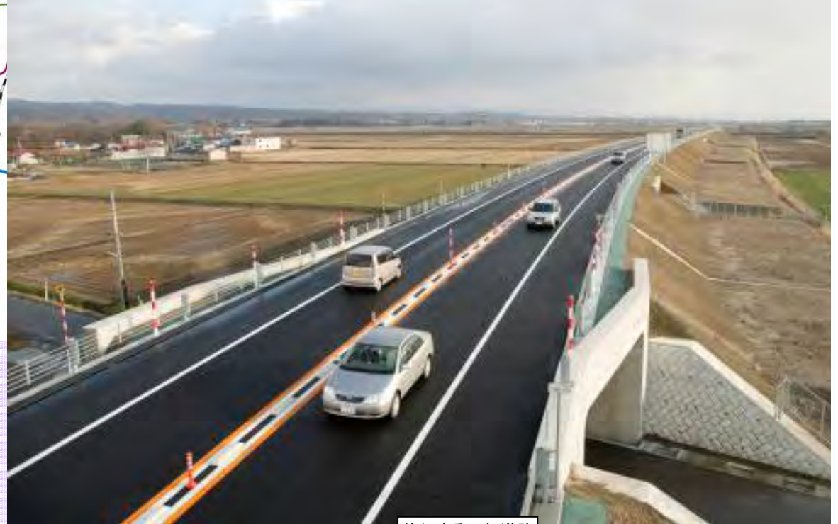
【開通した浪岡五所川原道路】
