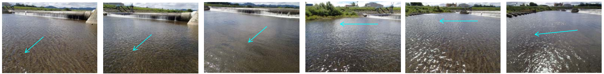
①堰下流(右岸) ②堰下流(中央) ③堰下流(左岸) ④水叩部(右岸) ⑤水叩部(中央) ⑥水叩部(左岸)
