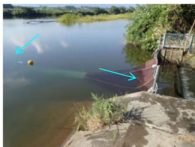
⑭左岸魚道出口
