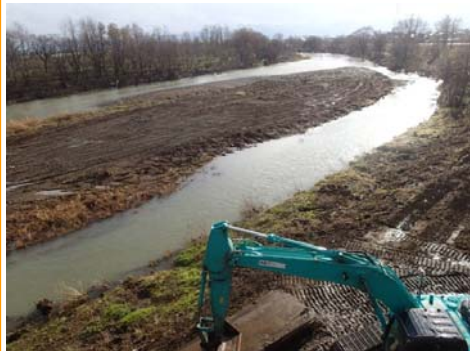
H25. 11. 28 (掘削工事後)
