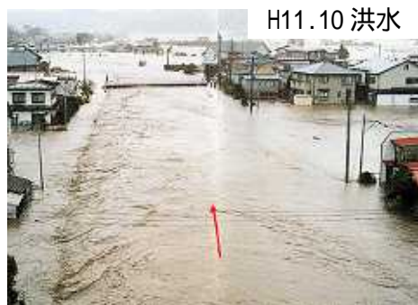
浅水川 八戸市三条目地内
