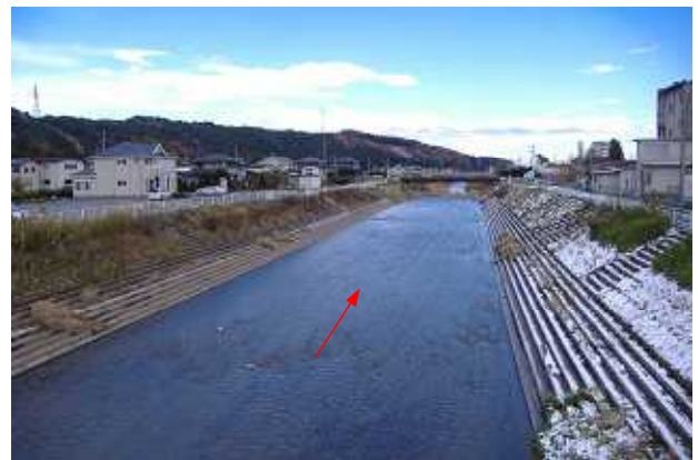
整備後（渡の葉橋～滝谷橋付近）
