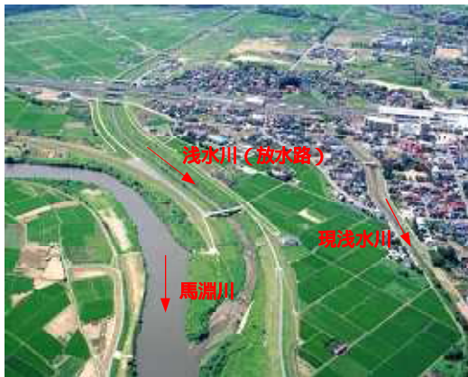
整備後（馬淵川合流点～渡の葉橋の放水路）
