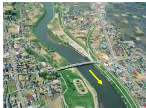
< 馬淵川下流部(大橋付近) >
