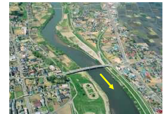
< 馬淵川下流部(大橋付近) >
