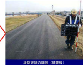
堤防天端の舗装（舗装後）
