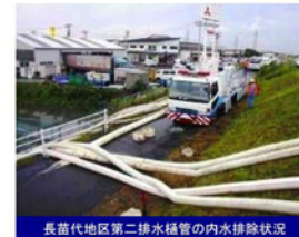
長苗代地区第二排水樋管の内水排除状況
