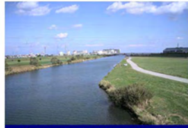
整備された高水敷の間をゆったりと流れる
