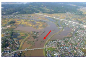
平成 16 年 9 月洪水 八幡・尻内地区(八戸市)の浸水状況
