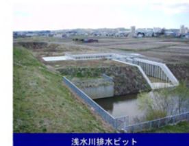
浅水川排水ピット
