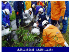
水防工法訓練（木流し工法）
