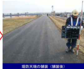
堤防天端の舗装（舗装後）
