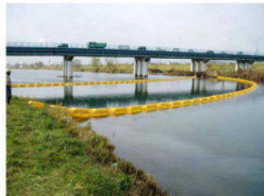
水質事故によるオイルフェンス設置状況（新大橋）
