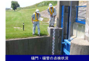
樋門・樋管の点検状況
