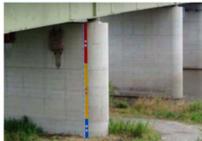
避難情報が発令される水位を表示している量水標（尻内橋）
