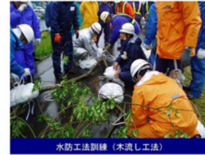
水防工法訓練（木流し工法）
