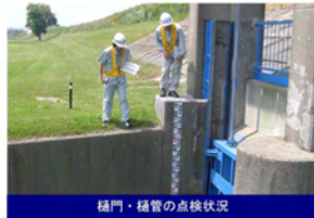
樋門・樋管の点検状況
