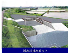
浅水川排水ピット
