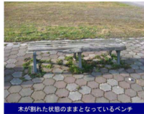
木が割れた状態のままとなっているベンチ
