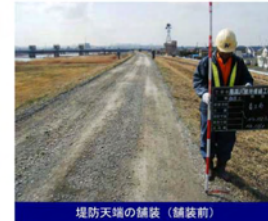
堤防天端の舗装（舗装前）
