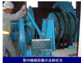
管内機械設備の点検状況
