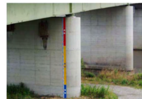
水位の危険度レベルを表示している量水標（尻内橋）
