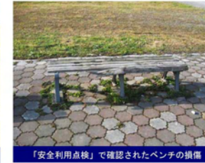
「安全利用点検」で確認されたベンチの損傷
