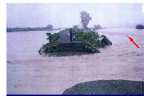
平成 2 年 9 月洪水 三戸郡南部町門前地区 左岸堤防の決壊状況
