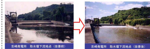
図 水利用者と連携した取水調整による河川環境の改善
