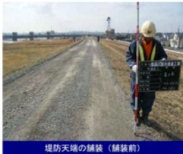
堤防天端の舗装（舗装前）
