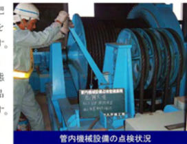
管内機械設備の点検状況
