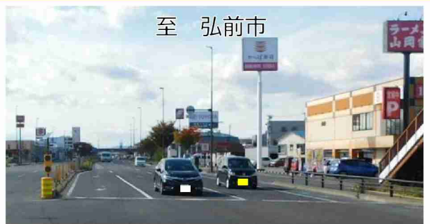
写真② 対策前の状況
