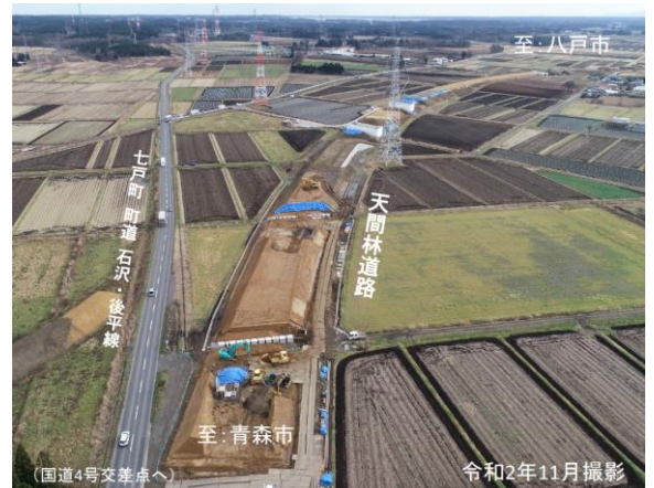
天間林道路 改良工事が進む後平地区の様子
