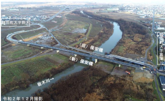
左岸堤防の築堤(引堤)を推進する岩木川中流部・鶴田地区
